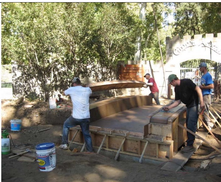
Figure 5 CA bridge pour
